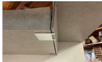
SSB工法PC裏段差部使用例（自社試算）
