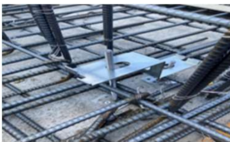
SSB工法立上段差部（AW基礎等）使用例（自社試算）
